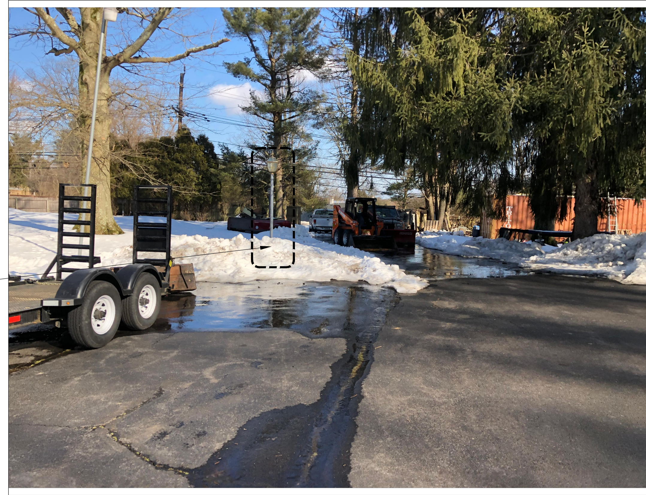
2 EXISTING REAR EXIT N.T.S.
