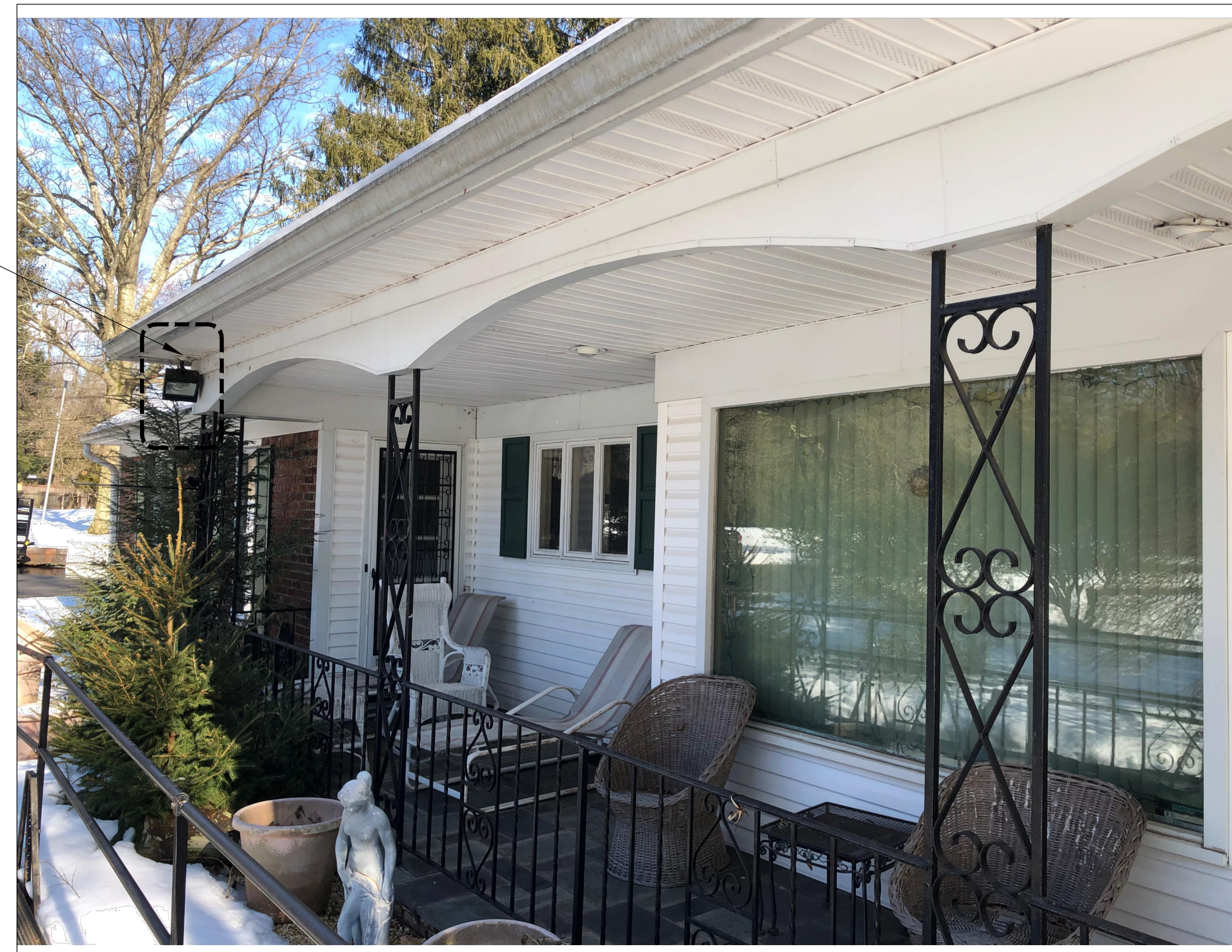
4 EXISTING FRONT PORCH N.T.S.
